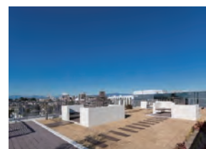
5F 屋上庭園 富士山と江ノ島が一望できます
