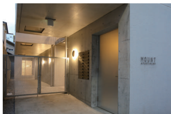
亀戸職員寮「MOUNT APARTMENT」のエントランス
